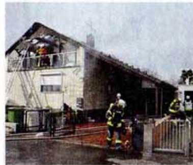
Das Einfamilienhaus ist vorerst wohl nicht mehr bewohnbar.
